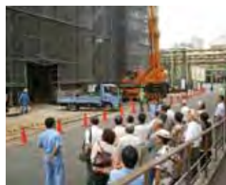
脱臭設備見学会
