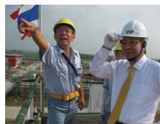
アユタヤ工場建設現場視察
