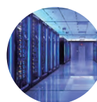
クラウド/ データセンター
