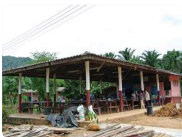
改築前の給食施設
