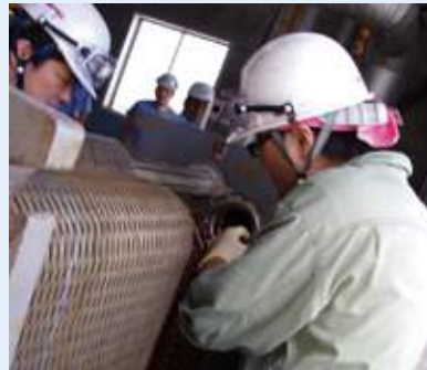
熱交換器を分解して1枚1枚丁寧に洗浄することで、安定した生産につなげる
