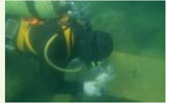
設置したコンクリートのモニタリング
