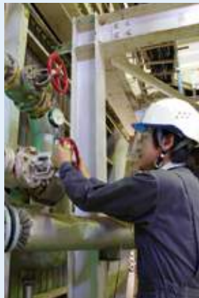
(右) バルブ一つひとつ開閉作業を確認
