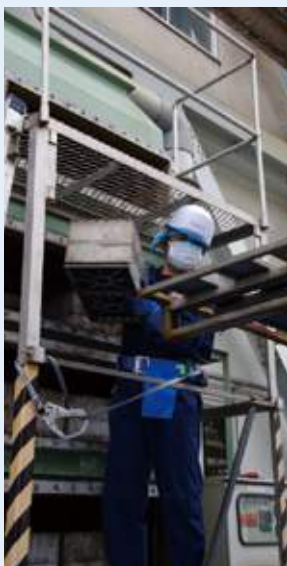
(左) 脱臭設備に使用する活性炭の交換作業
