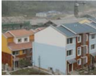
仮設住宅から恒久住宅に移転(2010年春)
