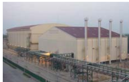
1万トンのもみ殻が貯蔵できる巨大なサイロ(写真奥)とボイラー(手前)
